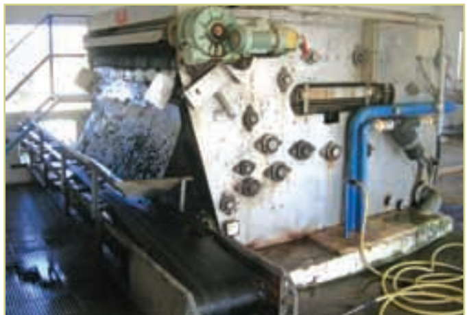
Foto 3.15. Secado mecánico de lodos: Filtros Banda. EDAR de Manilva (Málaga)
