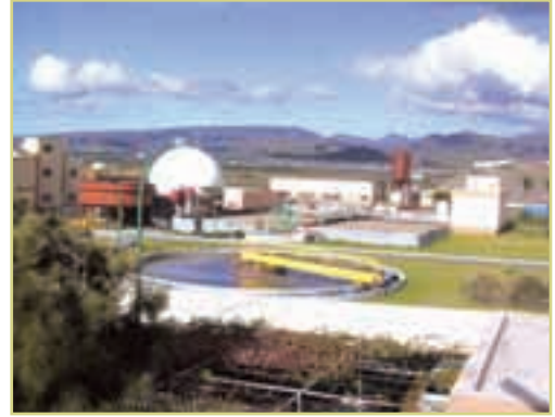
Foto 3.10. Detalle de EDAR del Sureste de Gran Canaria (Las Palmas)
