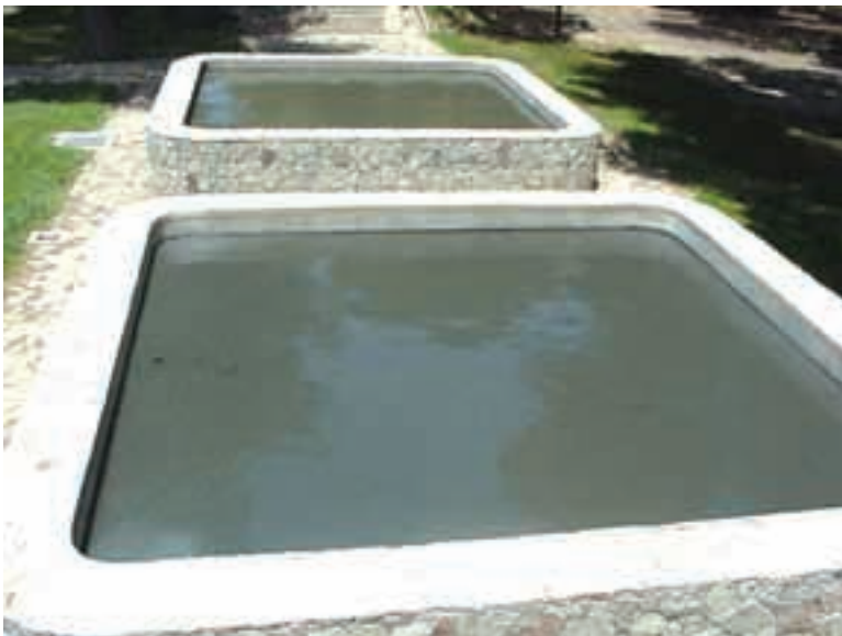
Foto 5.13. Lagunas Anaerobias. Centro de Transferencia Tecnológica (Tetuán).
