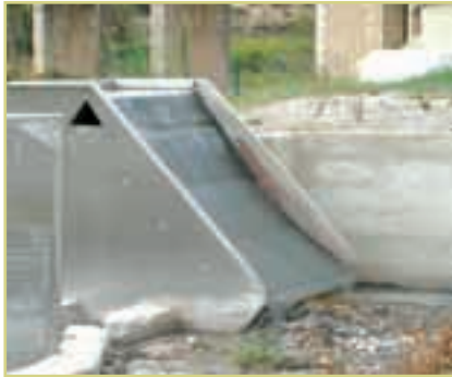
Foto 3.4. Tamiz estatico. EDAR de Fondón (Almería)
