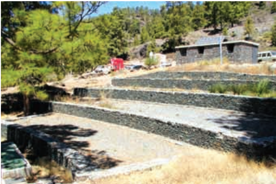
Foto 5.11. Humedal Artificial de Flujo Subsuperficial Horizontal. EDAR Área Recreativa Las Niñas (Gran Canaria - Las Palmas).
