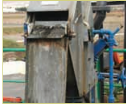
Foto 3.5. Tamiz rotativo. EDAR AENA Arrecife (Lanzarote-Las Palmas)
