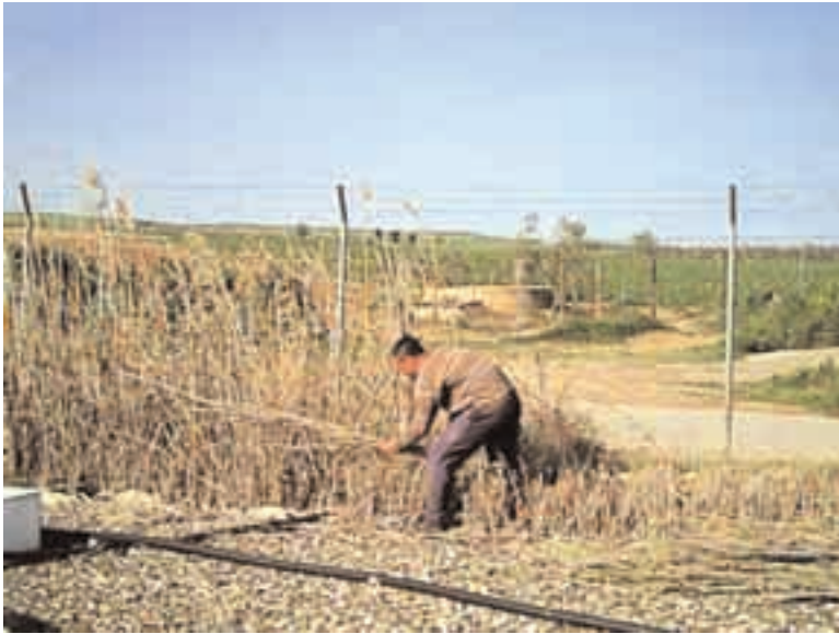
Foto 5.12. Labores de mantenimiento del Humedal Artificial.
